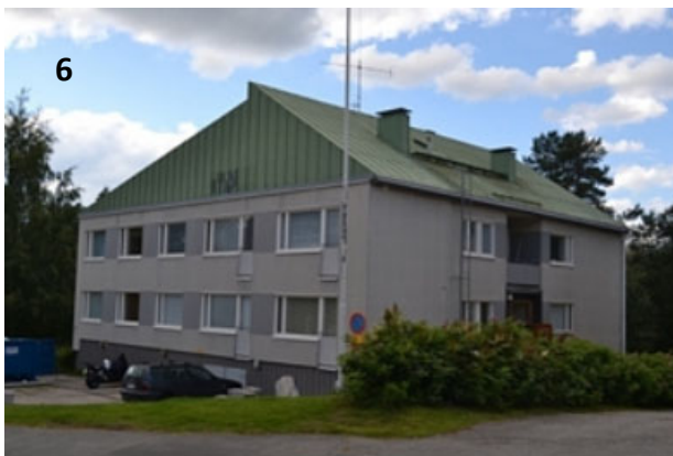
Mikkelissä vaikuttaneen arkkitehti Eero Jokilehdon suunnittelema asuinkerrostalo 1960-luvun alusta. Kulttuurihistoriallisesti merkittävä, kohteella on rakennushistoriallisia, historiallisia ja maisemallisia arvoja.
